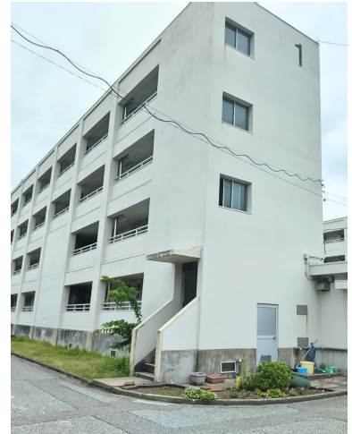
御坊山定住促進住宅
